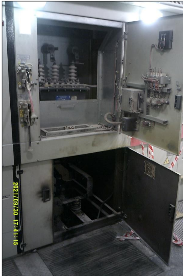
Место несчастного случая. Нижний отсек ячейки ТН и БРПЗ
