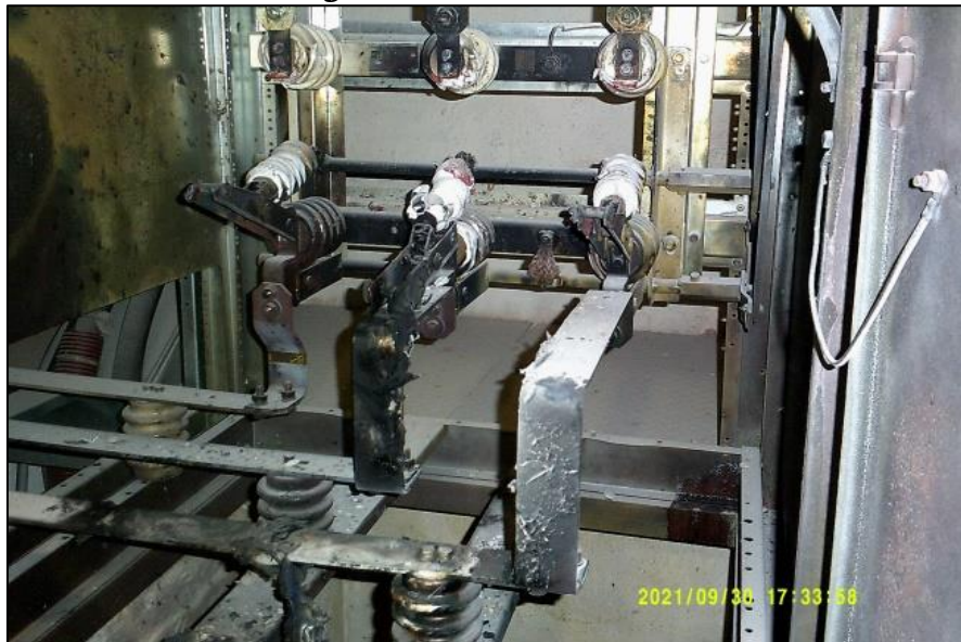
Место несчастного случая. Нижний отсек ячейки ТН и БРПЗ. Оборудование 6 кВ
